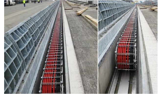
Caniveau et chaîne à câbles
